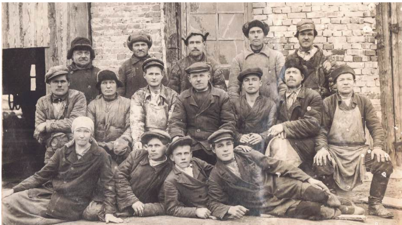
Коллектив ремонтно-строительного участка. 1937-1939 гг.
