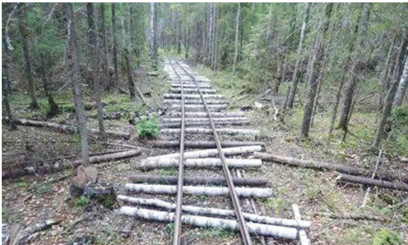
Лесная лежнёвая дорога (лежнёвка), на которой вместо металлических рельсов можно было использовать деревянные жерди
