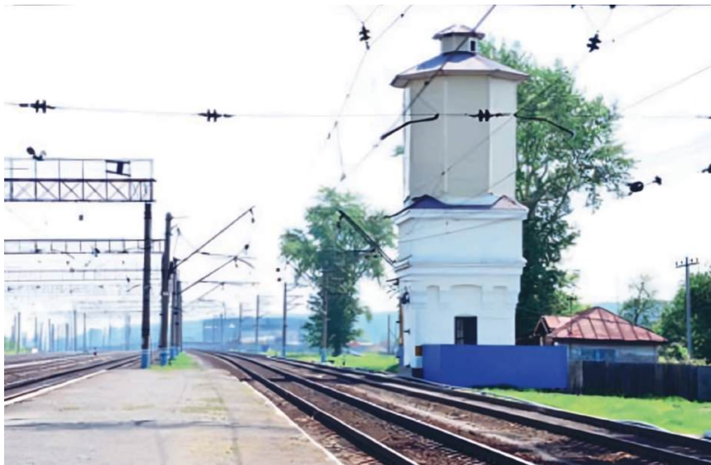
Водонапорная башня на станции Косулино
