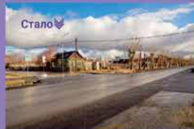
Ремонт дороги по ул. Горького
