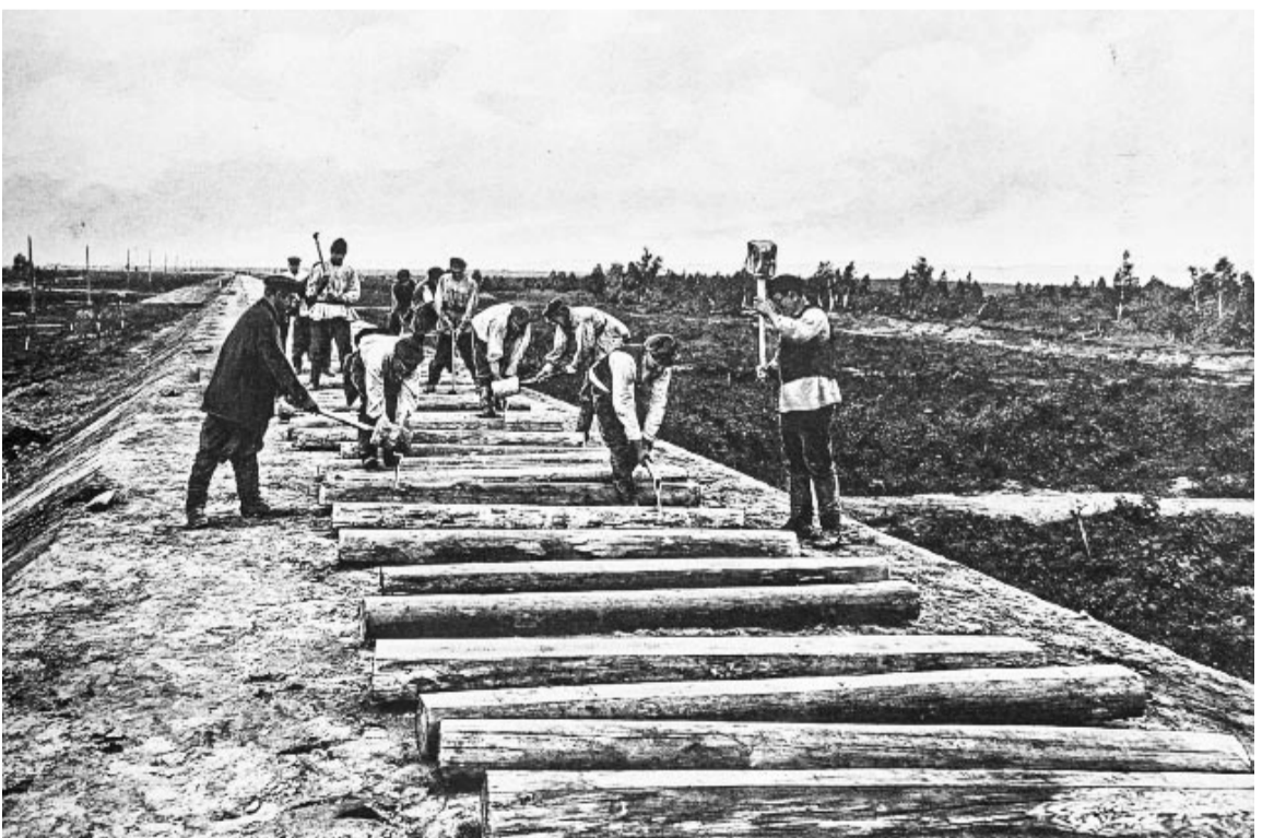
Строительство железной дороги во второй половине XIX в.
