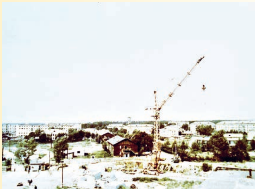
Строительство новых производственных корпусов на КАЗе
