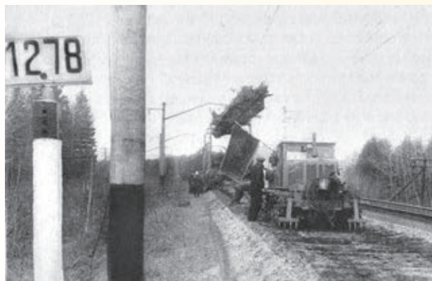
Переходящее Красное знамя находилось непосредственно при производстве работ в «окно»
